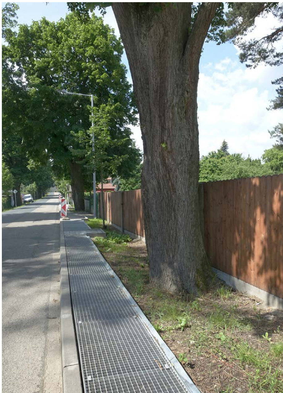
Příkladnou ochranou kořenových systémů lipové aleje v ulici Ringhofferova v Kamenici u Říčan, jež je zároveň registrovaným významným krajinným prvkem, bylo při budování chodníků lokální použití kovových lávek umístěných nad rostlým terénem.
