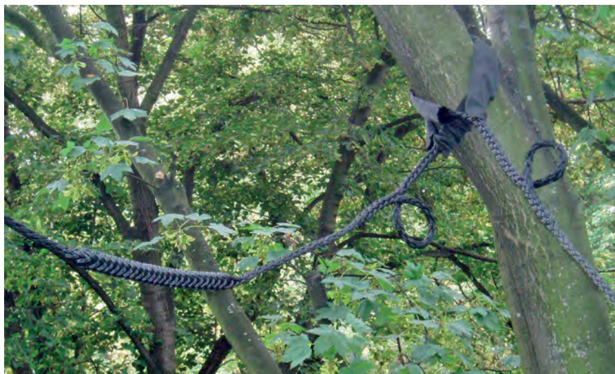
Obrázek 7-1 • Instalace 2 ks dynamické vazby Cobra Standard o nosnosti 20 kN (2t) v horní polovině koruny s tlumiči rázů a dutinkami kolem jištěných větví. Při instalaci většího počtu vazeb v koruně stromu v jedné úrovni mnohdy nezbývá než do jednoho větvení nainstalovat více než jednu vazbu (foto archiv Arbonet).
