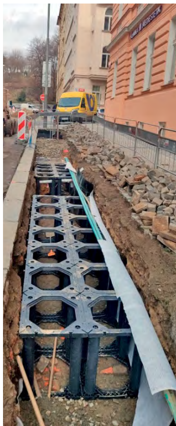
Obrázek 11-13 • Instalace půdních prokořenitelných buněk (VS-PB) v uličních stromořadích v ulicích Budečská a Blanická v Praze v letech 2017–2019 (foto archiv Odboru ochrany prostředí Magistrátu Hl. města Prahy).
