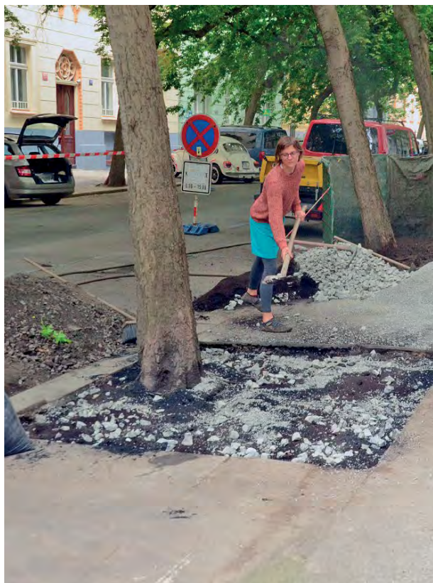
Obrázek 11-12 • Rozšíření volného prokořenitelného prostoru odstraněním asfaltového povrchu a výměnou vrchních 20 cm zhutnělé půdy za nové strukturální substráty (včetně použití aktivního biouhli) u břestovců západních v aleji v ulici Lužická v Praze 2 v roce 2020 (foto archiv Arbonet).
