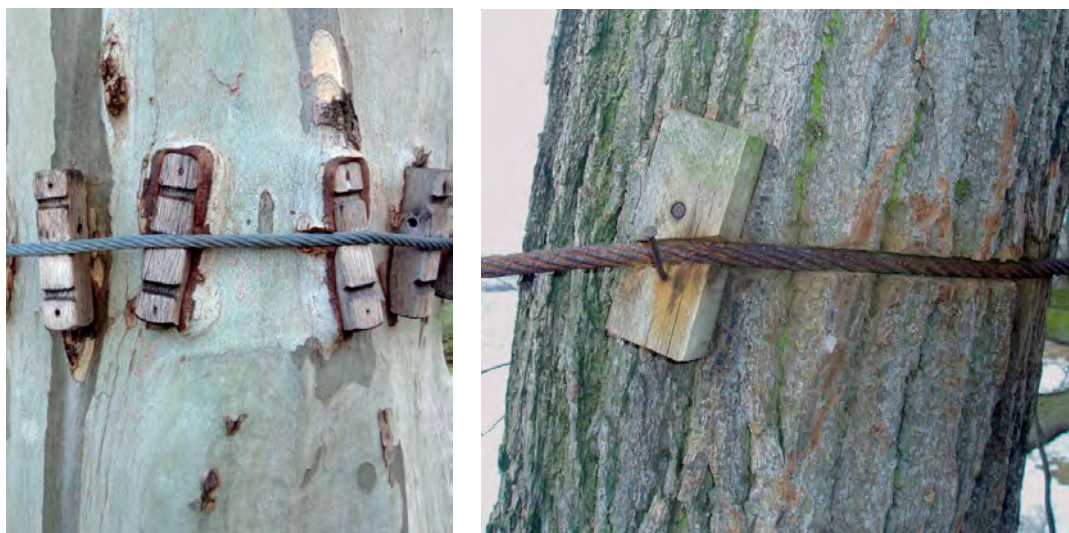
Obrázek 7-11 • Podkladnicové vazby je nutné pravidelně kontrolovat. Podkladnice i ocelová lana zarůstají do jištěných větví a způsobují tak nemalá mechanická poškození (foto archiv Arbonet).
