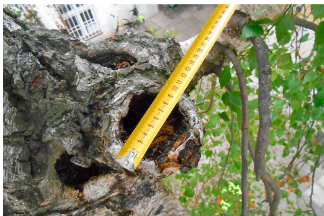
Obrázek 6-28 • Nevhodně odstraněné velké větve na bříze v přeslenitém větvení způsobily propojení infekce a následné hniloby, která destabilizovala celý kmen (foto archiv Arbonet).
