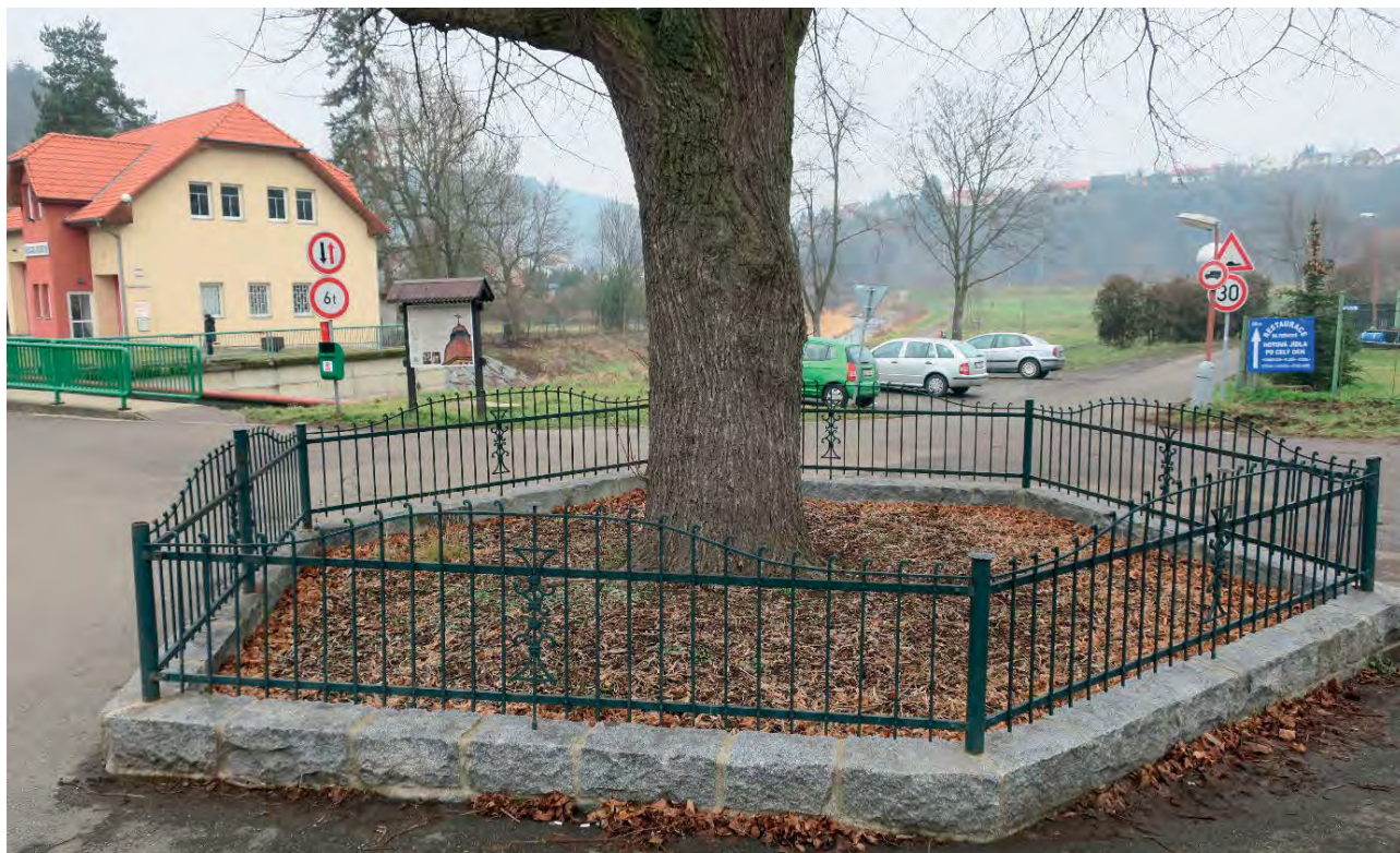
Obrázek 8-14 • Kovové oplocení na žulové podezdívce u jubilejní lípy ve Štěchovicích zřetelně vymezuje nejbližší okolí stromu a působí jako účinná mechanická zábrana proti pojezdu báze kmene, kořenových náběhů a kořenů (foto archiv A. Rudla).
