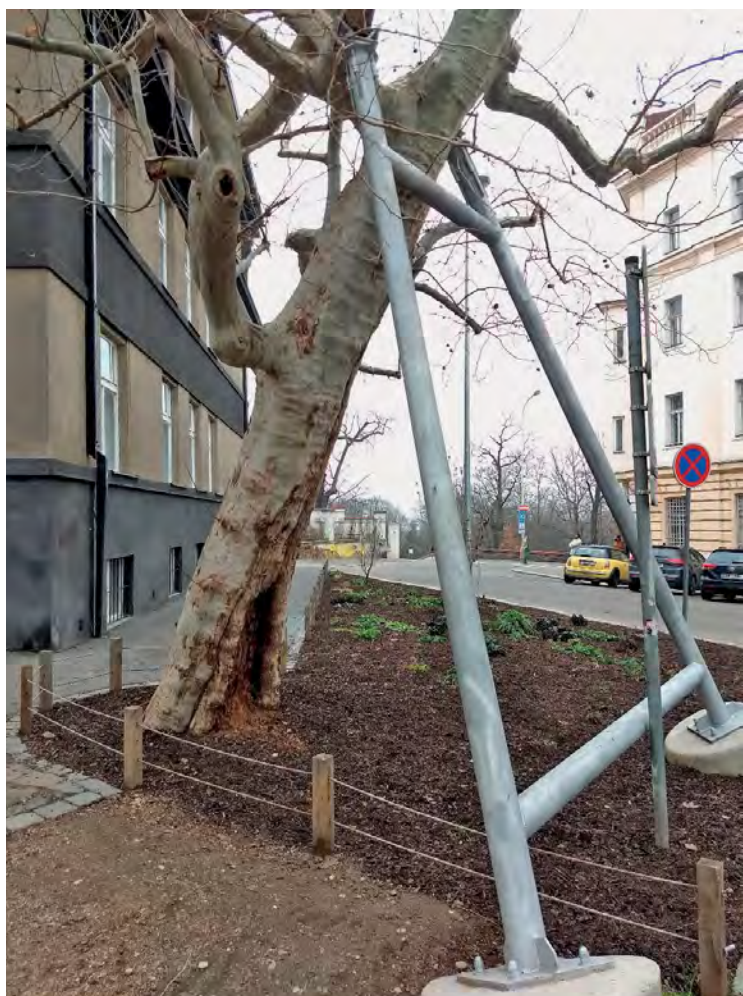
Obrázek 7-16 • Masivní podpěra ve tvaru písmene A na vykotlaném a nad křižovatkou ulic v Praze 7 vykloněném platanu u historické budovy Škola architektury AVU ČR, jejímž cílem je zamezit velmi nestabilnímu jedinci v samovolném vývratu či zlomu kmene v duté bázi u země (foto archiv Arbonet).
