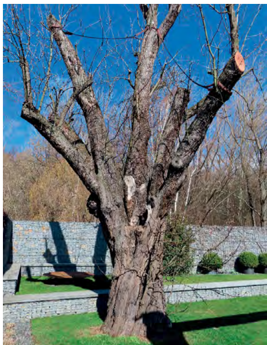
Obrázek 6-59 • Sesazovací řez (VS-RS) památné hrušně s rozsáhlou hnilobou dřeva kmene a otevřenou dutinou a rozpadajícím se kosterním větvením (foto archiv Arbonet).
