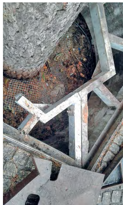
Obrázek 8-13 • Důmyslný systém ochrany bází kmenů, kořenových náběhů a kořenů borovic lesních nejen proti jejich ošlapu, ale i pojezdu těžké mechanizace. Žulová dlažba na náměstí v holandském Apeldoornu (Evropském městě stromů 2018) je nesena masivní ocelovou konstrukcí, pod níž se v hloubce cca 0,5–1,5 m nachází původní provzdušněný terén se stromy opatřenými kapkovou závlahou, tak aby dešťová voda v podzemních rezervoárech poskytovala stromům dostatek vláhy, a přitom jejich volný kořenový prostor zůstal nepoškozený (foto archiv Arbonet).
