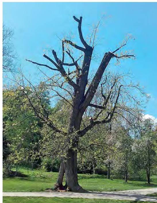
Obrázek 6-60 • Sesazovací řez (VS-RS) dubu velkoplodého s rozsáhlou hnilobou kmene po požáru bazální dutiny, pražská Stromovka, jaro 2016 (foto archiv Arbonet).
