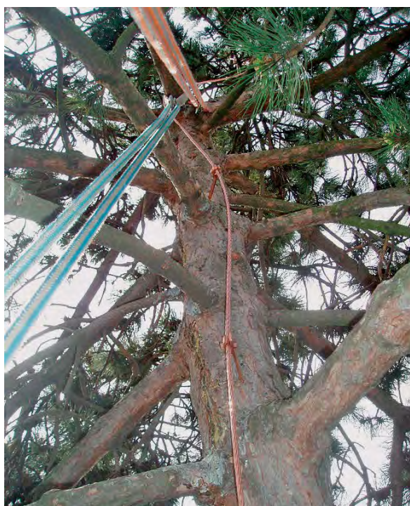
Obrázek 8-1 • Instalace hromosvodu do bleskem poškozené borovice černé (foto archiv Arbonet).
